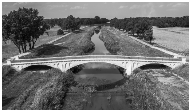
Sonderpreis im Rahmen des Brandenburgischen Baukulturpreises 2021 | Gewölbebrücke Neudeck | Foto: Andreas Franke
