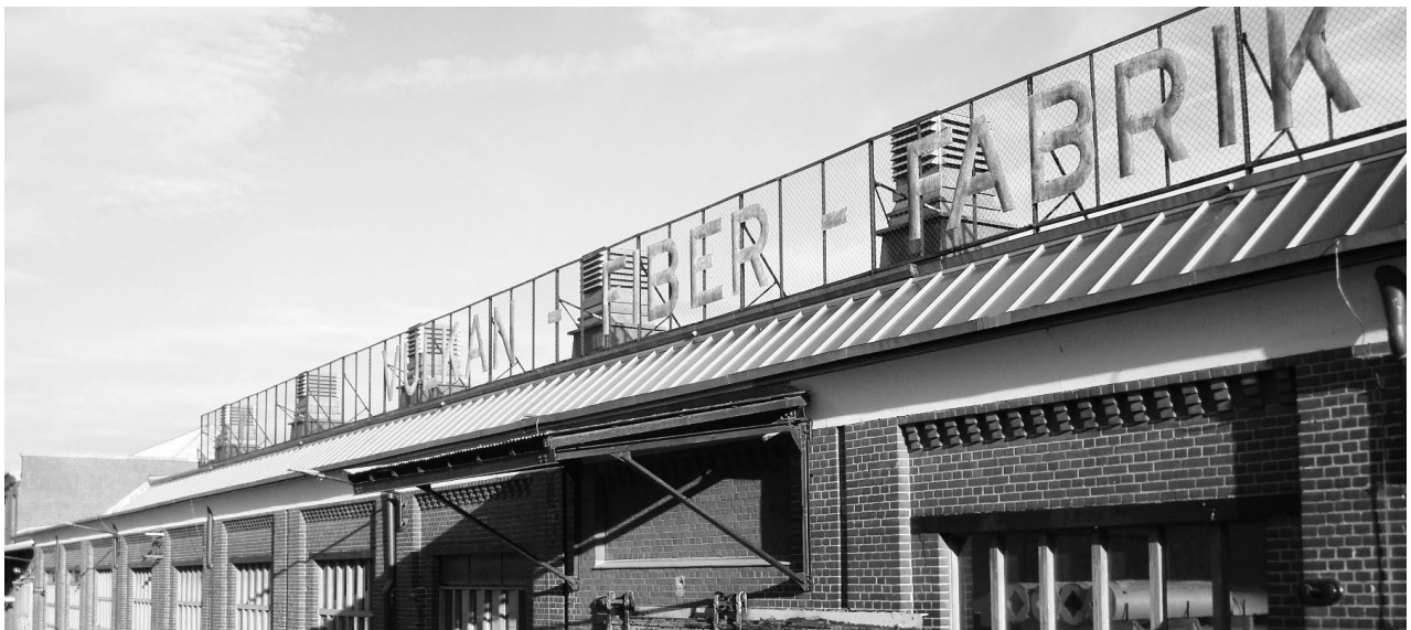
Nordansicht des Gebäudes A | Foto: Dr. Jörg Maywald (Eigentümer)
