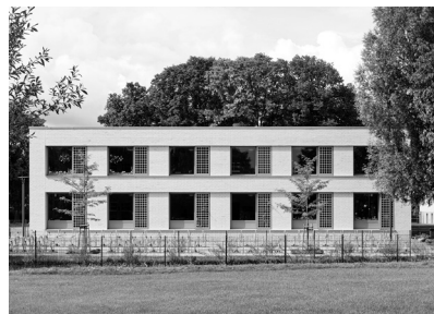
Grundschule Zepernick © ARGE Renner Architekten und Bollinger + Fehlig Architekten
