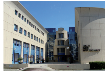
Geschäftsstelle der Brandenburgischen Ingenieurkammer
