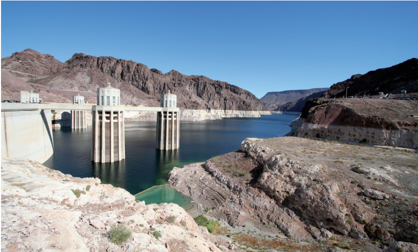
Abb. 3.1.8.2 Wasserkraftwerk | Quelle: Fotolia
