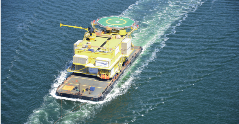
Abb. 3.1.6.1: Transport Offshore Umspannwerk Nordsee Quelle: Dr. Born – Dr. Ermel GmbH
