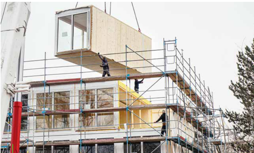
Hohe Vorfertigung, schneller Bau: Anlieferung eines Raum-Moduls inkl. Fenstern
