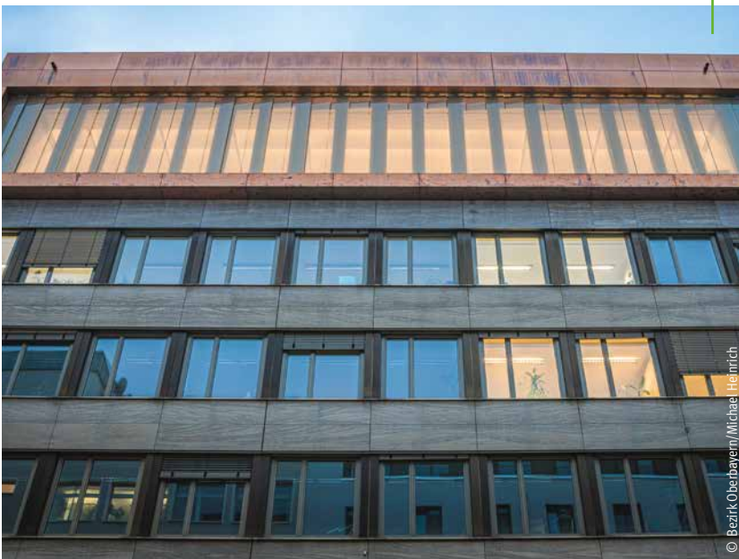
Außenverkleidung mit Kupfer
