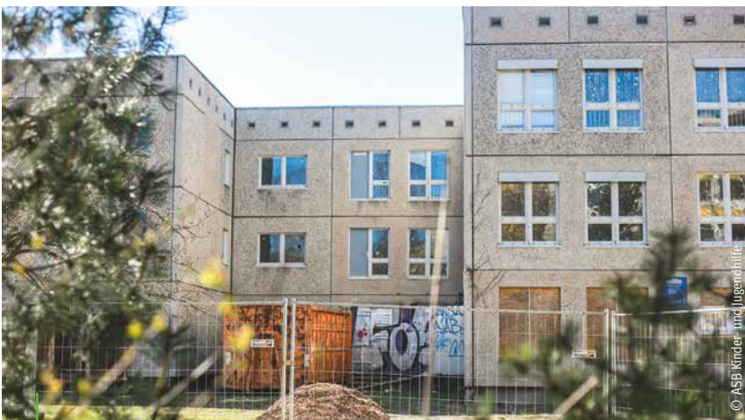
Bau aus den 1980er-Jahren vor der Sanierung
